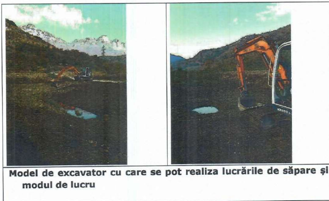
Figure 16. Model de excavator cu care se pot realiza lucrările și modul de lucru
